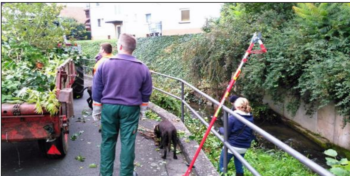
Arbeiten am Riedbach. Rückschnitt von Büschen.
